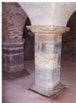
Pilastro centrale sala capitolare, con capitello in pietra rosata
